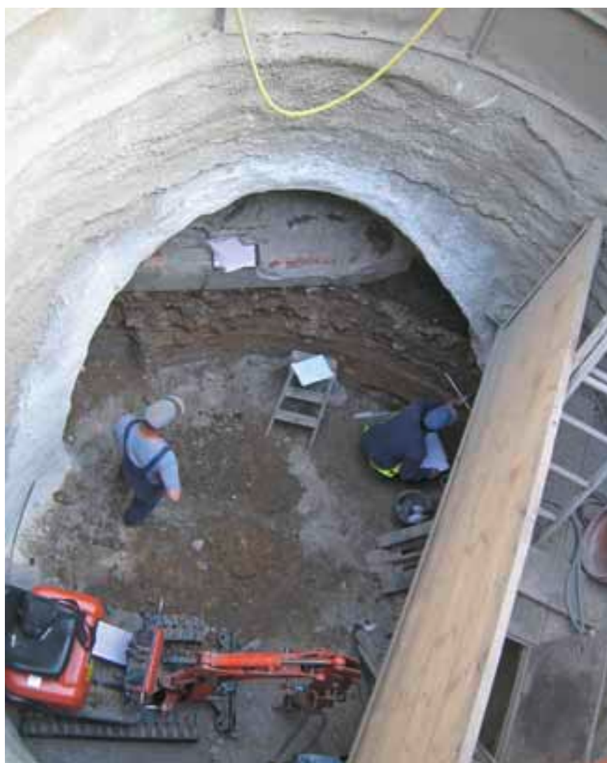
Neben Pinsel und Kelle kommt auch schweres Gerät im Hof zum Einsatz.
