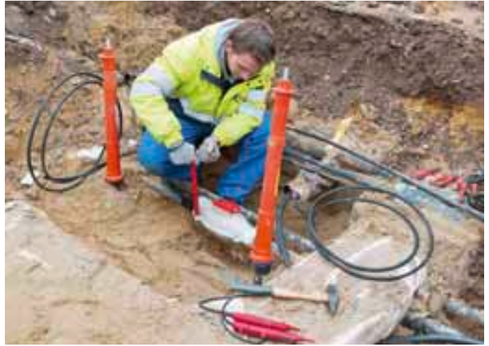
In Neubaugebieten verlegen die Netzmonteure die Leitungen und schließen die Häuser ans Netz an.
